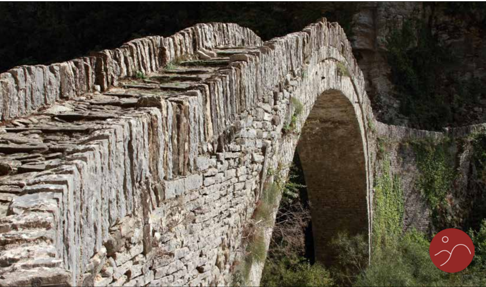
Il ponte di pietra Kokori. Parco del Pindo, Vikos - Epiro, Grecia
