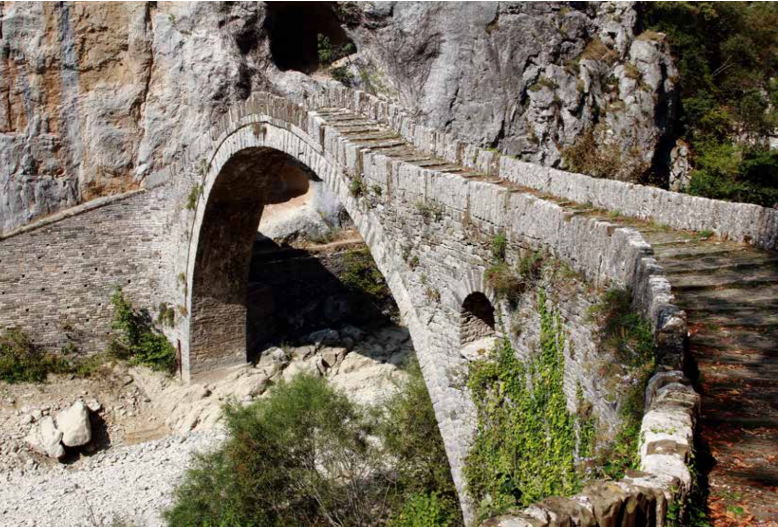
Il Ponte Kokkori (1750) Parco Nazionale del Pindo - Epiro, Grecia
